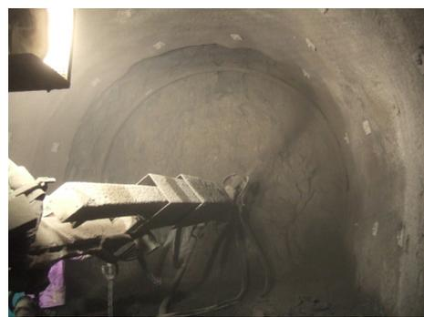
写真-2 液状急結剤を用いた施工状況
