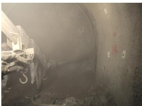
写真-1 スラリー状急結剤を用いた施工状況
