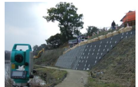
写真-1 施工事例
