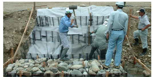
写真-3 プラ粗朶柵設置状況
