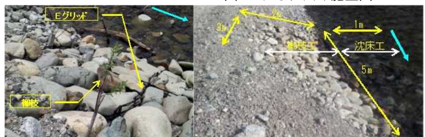
写真-4 施工後 8 ヶ月 左:柳枝の若葉, 右:プラ粗朶工法全景
