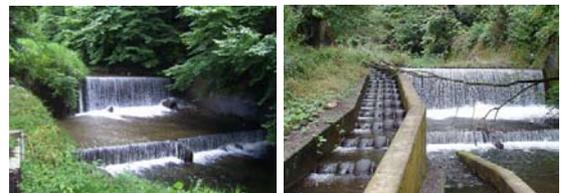
施設①改修前直壁落差工(左)と改修後部分魚道(右)
