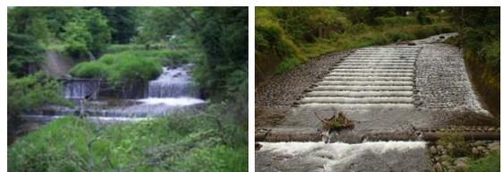
施設②: 改修前直壁落差工(左)と改修後全断面魚道(右)
