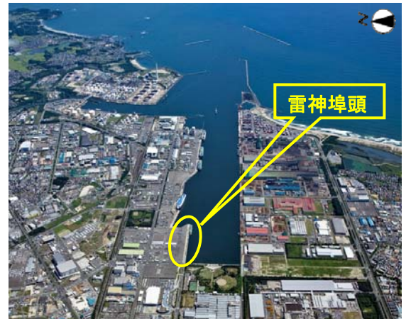
写真-1 仙台塩釜港 雷神埠頭位置
