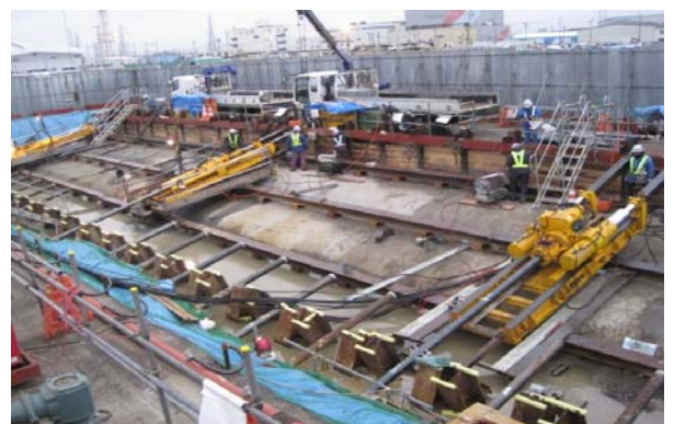
写真-4 小口径推進機による削孔状況
