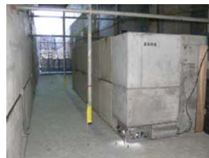
写真1 計測機器設置状況
