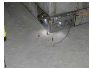
写真2 先頭方塊観測部の様子
