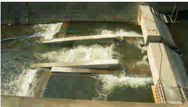
写真1 分水堰に魚道整備されたばかりの状態
