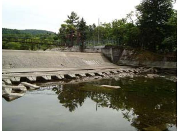
写真1 低落差直下流側での侵食状況
