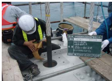
外面補修状況 (ペトロラタムテープ+防食テープ)
