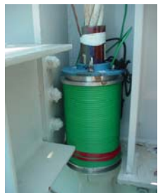
全磁束法による断面計測
