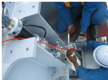
内部充填材圧入状況 (ペトロラタムペースト)
