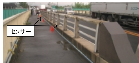
写真-1 G5山側の測定状況
