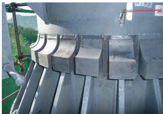
図3 樹脂ブロックの施工状況
