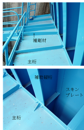
写真1 スキンプレート周辺
