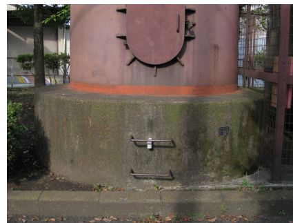
写真-1 照明設備の基礎構造
