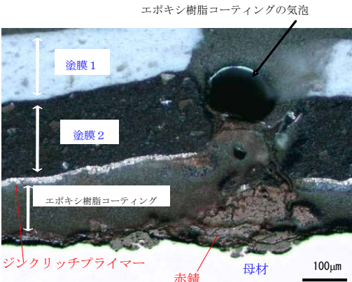
図-4 塗膜割れ部の断面
