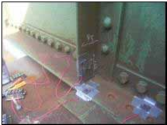
写真-1 貼付け状況
