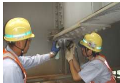
写真-1 鉄けた特別検査状況
