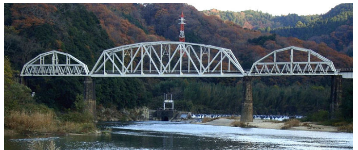
写真1 木津川橋りょう全景 (1～3連目)
