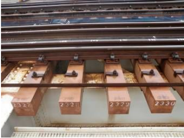
図.1 鋼鉄道橋(開床式)
