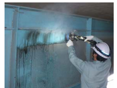
写真-4 洗浄実施状況(2)
