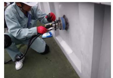
写真-3 洗浄実施状況(1)
