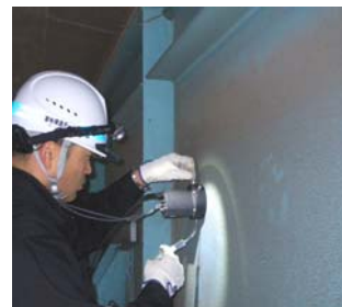
写真-8 付着塩分計測状況
