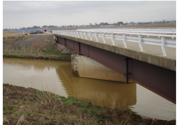
写真 1 対象橋梁全景
