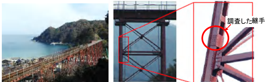
図. 2 試験体を取り出した橋梁
