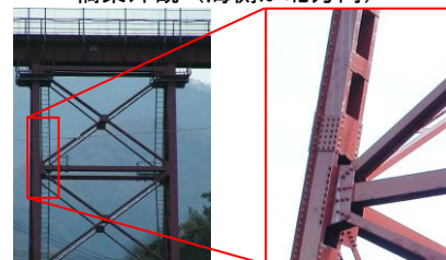
橋脚の外観 主材部分の拡大写真
