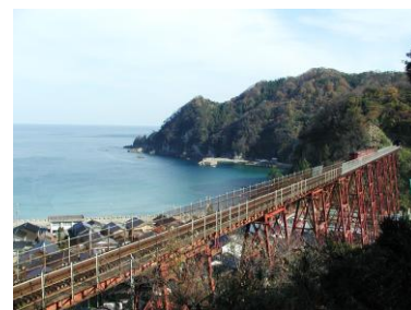
橋梁外観（海側が北方向）
