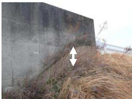
写真4 国道357盛土沈下の様子
