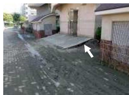
写真6 柴町住宅内地盤沈下
