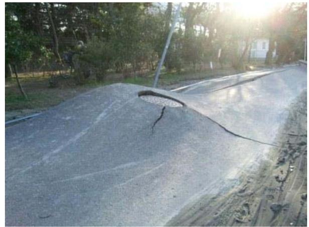
写真1 習志野市での液状化被害の様子
