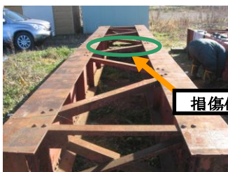
図-1 実験橋梁(A-2 から)
