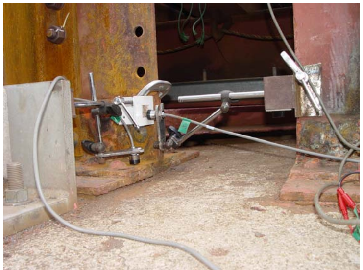
写真2. 桁下端付近の計測装置取り付け状況
