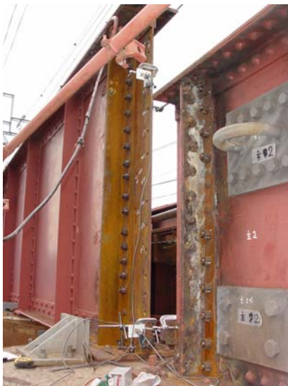
写真1. 桁端水平変位計測状況
