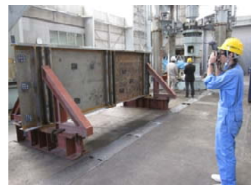
写真2 デジタルカメラ3次元計測状況
