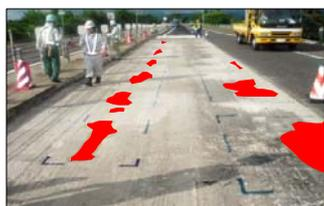
写真-2 浮き損傷 (赤着色部)
