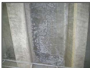
写真-5 床版下面の損傷
