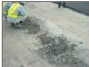
写真-3 床版上面の損傷
