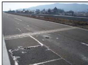
写真-4 舗装の損傷 (橋梁部)
