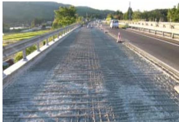
写真-1 RC 床版損傷箇所はつきり取り状況
