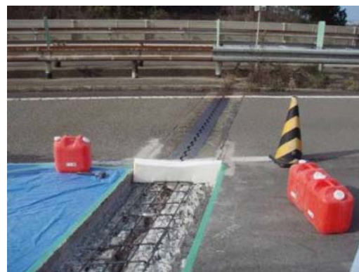
写真-1 RC 連結ジョイントの配筋状況
