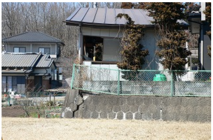
写真2 擁壁の被害
