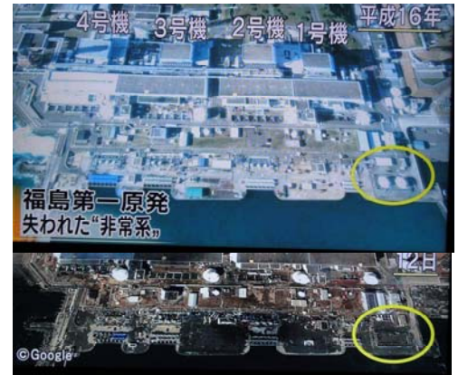
写真-1 護岸のすぐ近くに配置された非常系施設(2011.3.16 放映のテレビ画面を撮影・合成)
