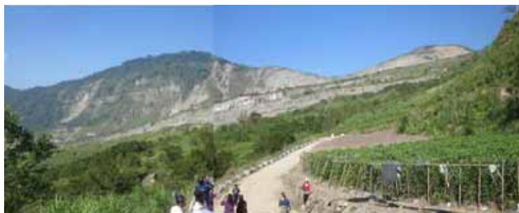
図-2 2010 年の草嶺の崩壊斜面の復旧状況
