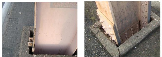
図-2 鋼材の変状
