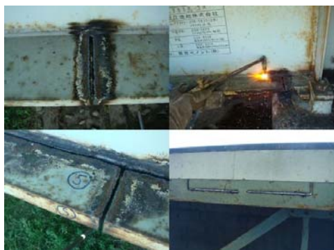
図4 ガス切断の様子
