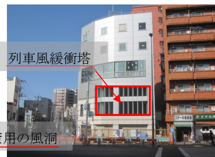
写真-2 現況写真【地上部】
