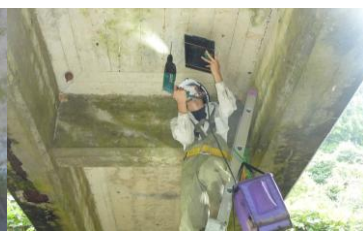
図 3. 中性化深さ確認
