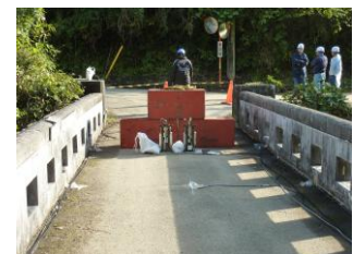
図 5. 振動測定状況
