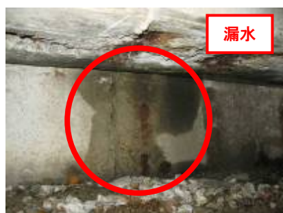
図3 伸縮装置の継ぎ目からの漏水
