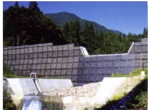
写真-1 鋼製枠砂防堰堤
