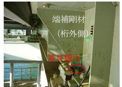
写真-1 調整桁端部の端補剛材
