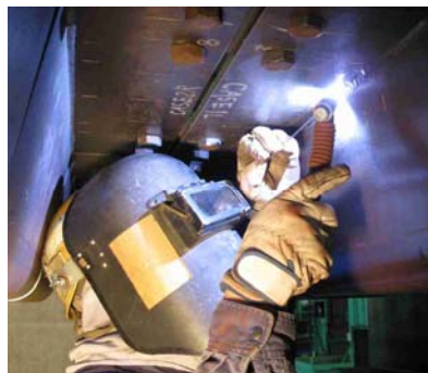
写真-1 TIG 溶接状況
