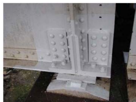
写真 2 3 面当板工法（従来型） 1)
