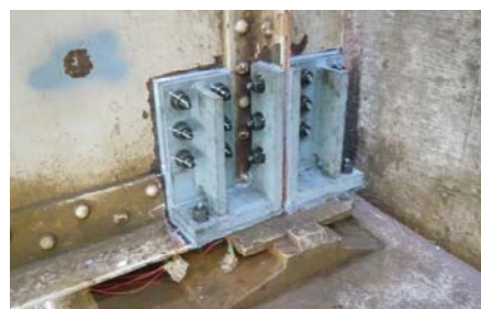
写真2 3面当板施工後
