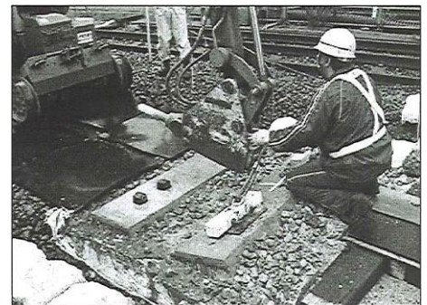
図-5 TCまくらぎ撤去施工試験状況
