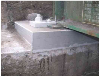
写真-7 施工完了写真
