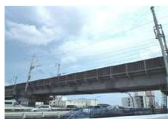
写真－2 対象橋りょう全景
