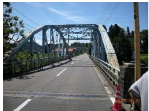
図 2 振動計測対象橋梁
