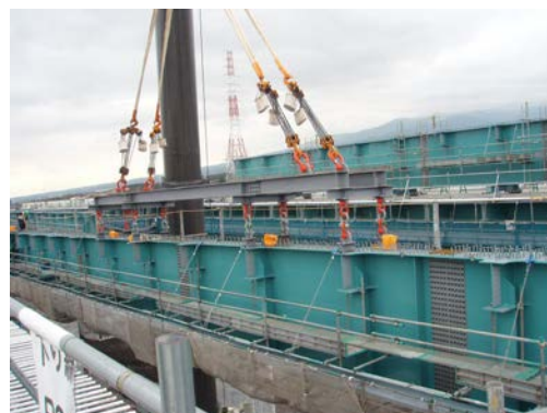
写真1 御殿場高架橋（桁架設時）
