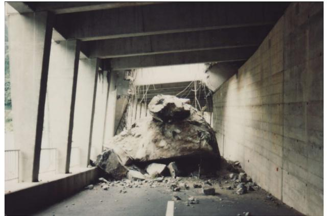
写真-1 落石により破壊したロックシェッド
