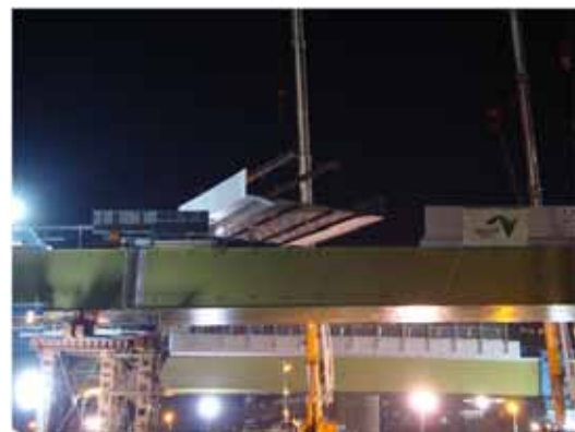
写真-2 床版架設状況
