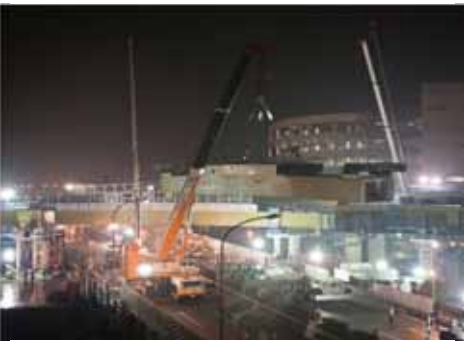
写真-1 桁架設状況
