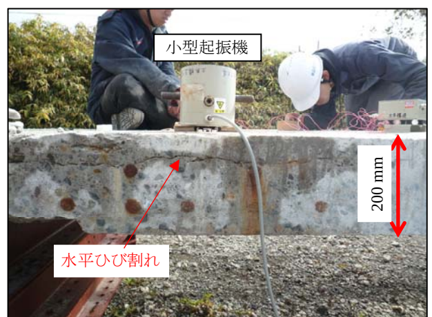
写真-2 測定状況
